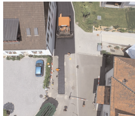
Blick auf den Einbau des Deckbelages an der Hinterdorfstrasse in Lindau aus der Vogelperspektive. Die Flugaufnahme entstand während der Bauarbeiten.
